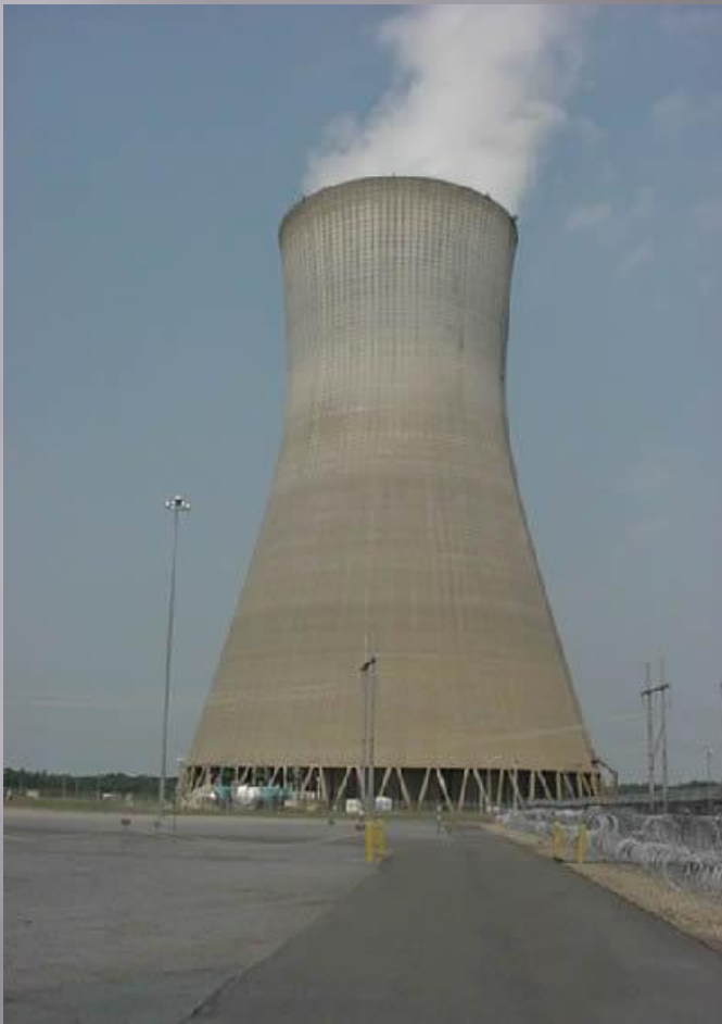
Vapor saindo da torre de refrigeração da usina.
